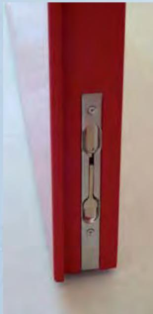
Unterer Riegel für feststehenden Flügel der Doppelflügeltür
