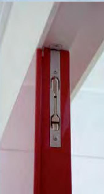
Oberer Riegel für feststehenden Flügel der Doppelflügeltür
